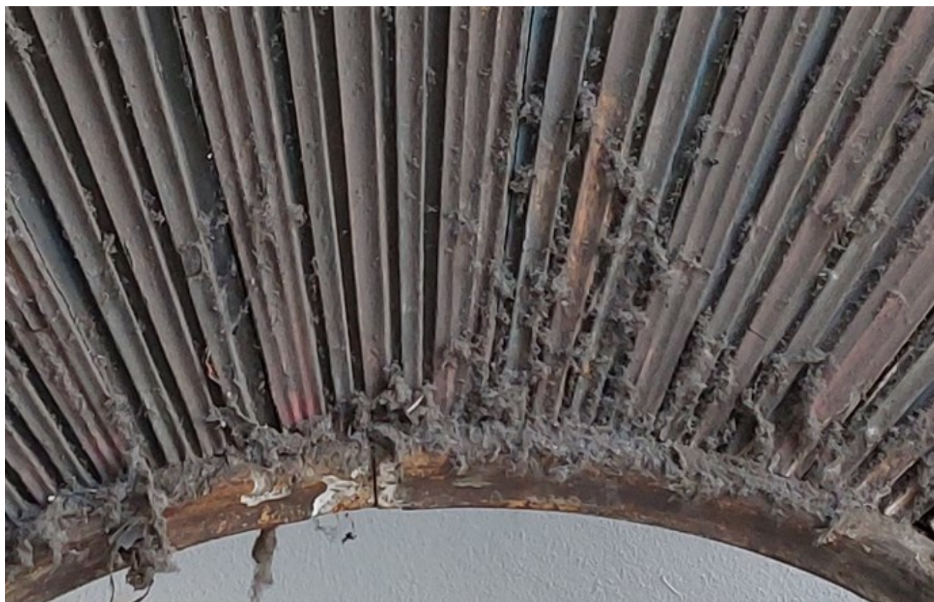
Tipologia del degrado: depositi superficiali presenti
