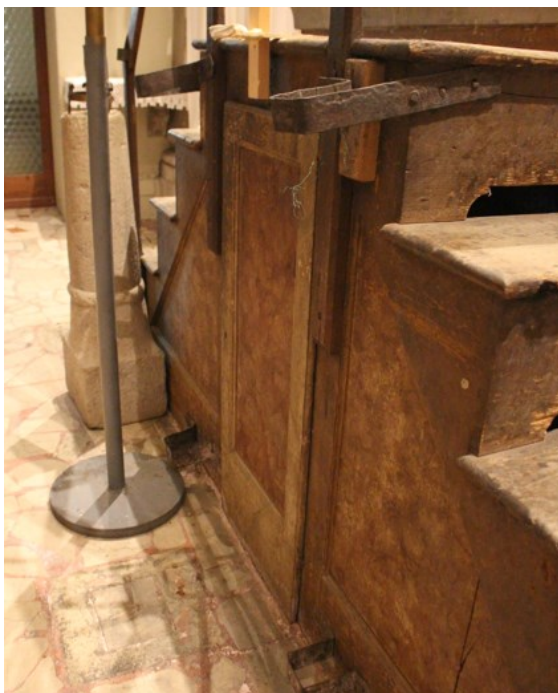
Ganci residui e staffe in ferro sulle pareti per il fissaggio della struttura originale di sostegno in Parrocchiale
