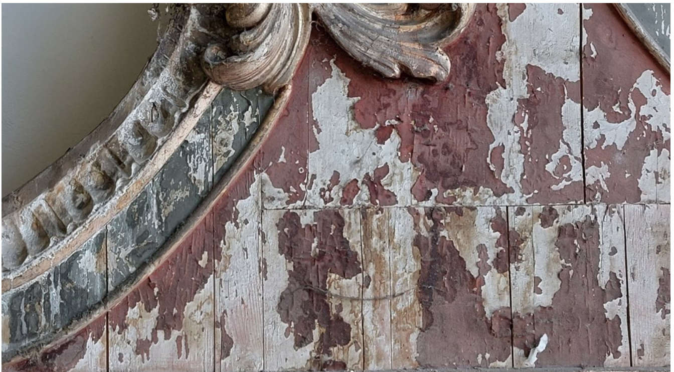
Tipologia del degrado: depositi superficiali presenti
