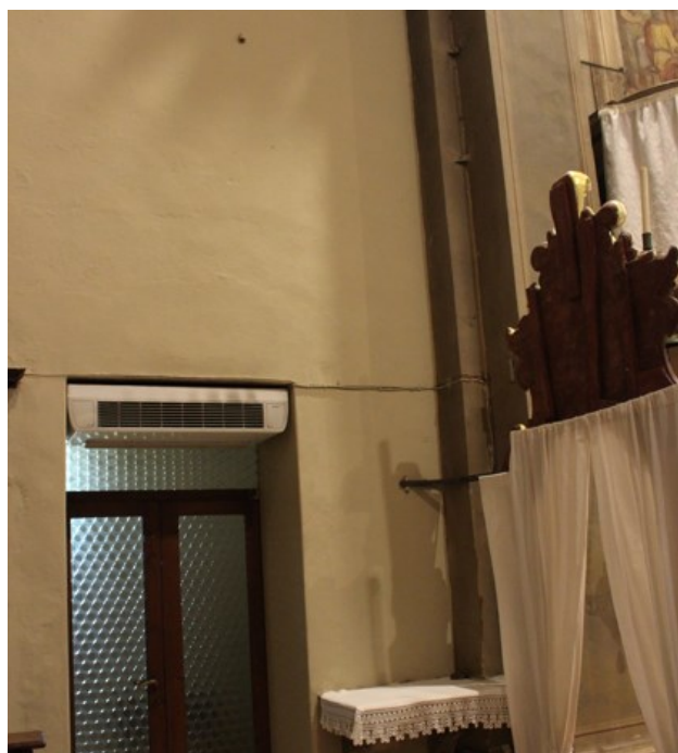
Ganci residui e staffe in ferro sulle pareti per il fissaggio della struttura originale di sostegno in Parrocchiale
