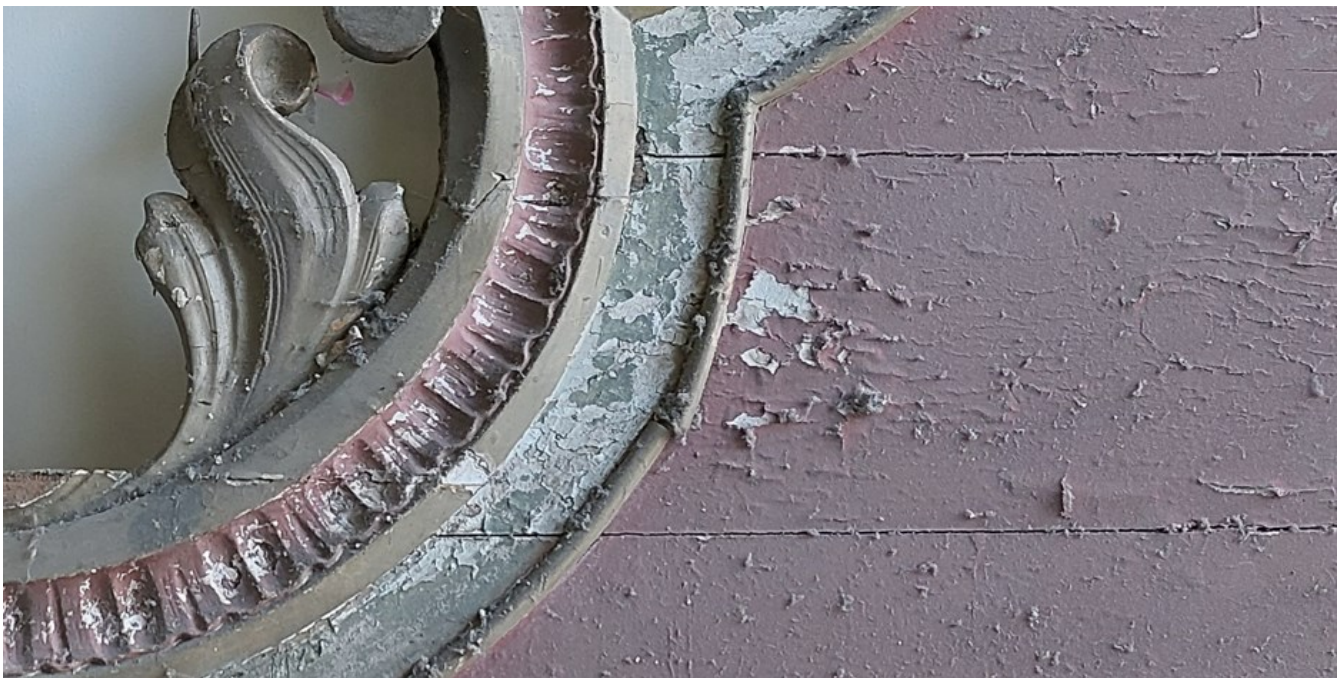
Tipologia del degrado: depositi superficiali presenti
