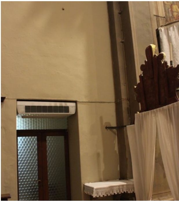
Ganci residui e staffe in ferro sulle pareti e sulla scala dietro l'altare per il fissaggio della struttura originale di sostegno al triduo
