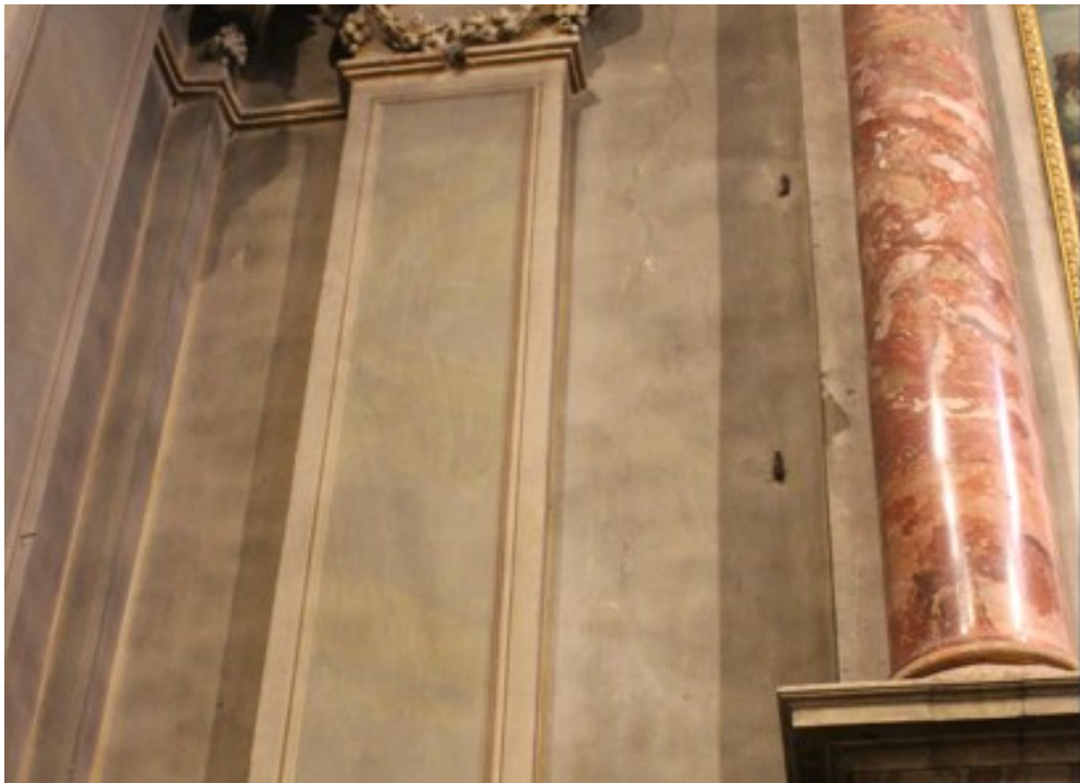
Alcuni dei ganci superstiti sulle pareti dell'abside che servivano per ancorare la struttura di sostegno al triduo
