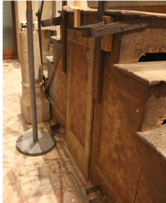
Ganci residui e staffe in ferro sulle pareti e sulla scala dietro l'altare per il fissaggio della struttura originale di sostegno al triduo
