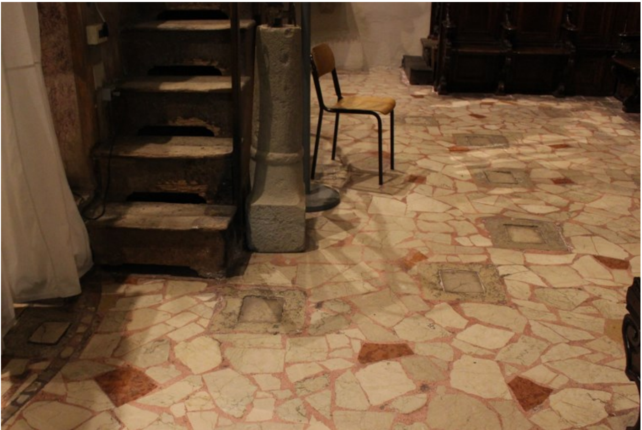
Fori sul pavimento dell' abside e sulla pedana del coro in Parrocchiale per i verticali della struttura di sostegno
